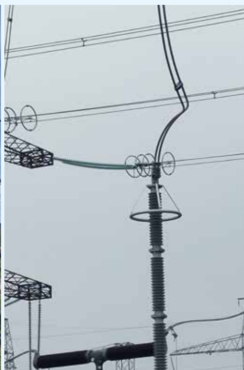
Rozdzielnia w czasie modernizacji
