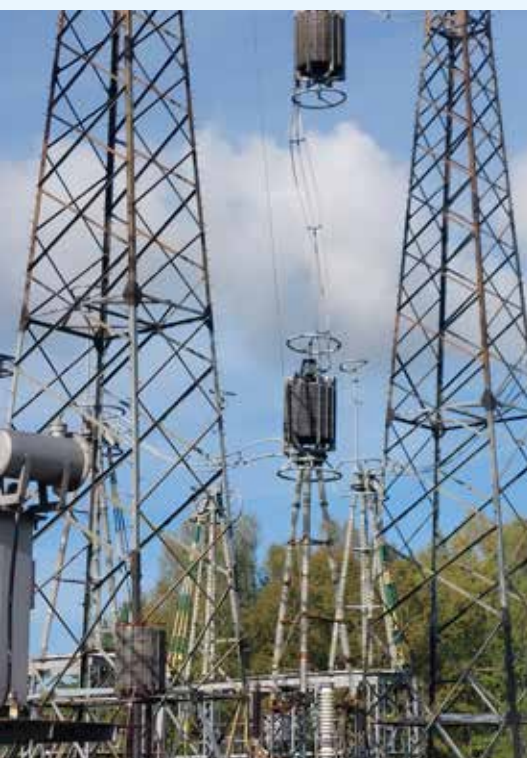
Przedpole linii 750 kV do modernizacji
