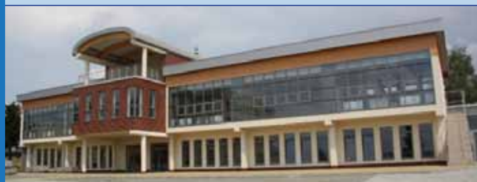
Centrum Innowacji i Wdrożeń w Przemśle Spożywczym oraz Centrum Przetwarzania Biomasy i Odpadów na Energię
